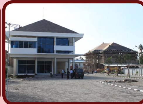
Proses pembangunan Balai Diklat BPK RI di Medan
